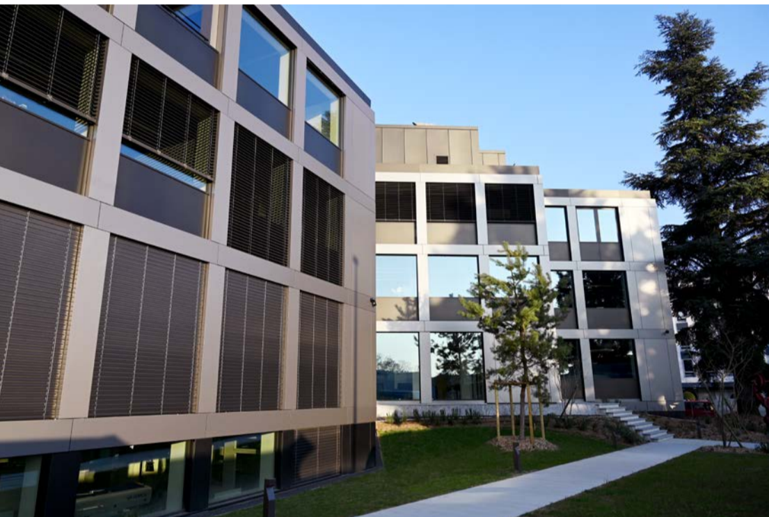
Nouveau bâtiment regroupant les Cadraniers de Genève et les Boîtiers de Genève situé à la rue de Veyrot 23 à Meyrin, Genève.
