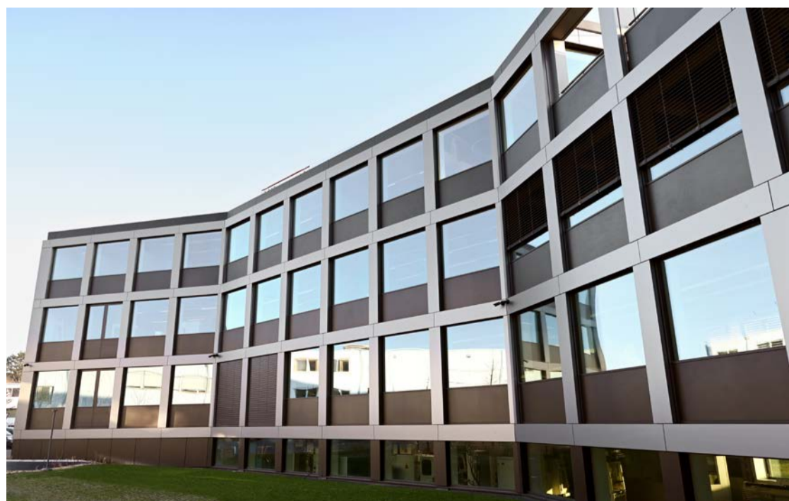
Façade du bâtiment côté parking.
